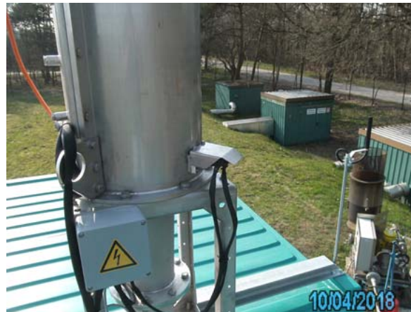
Rückbau Mobile Testtechnik Baureihe DMF (DAS-IB GmbH) – IBN stationäre CHC - Anlage
